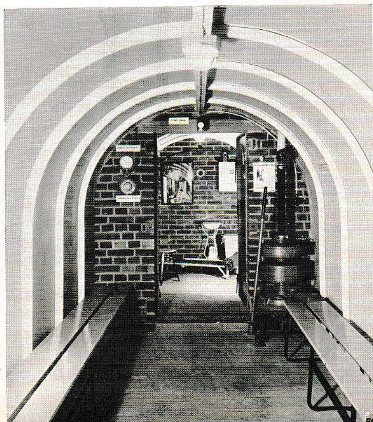
Fig. 246. Abri en tôles nervurées prenant appui sur une poutre faîtière.
