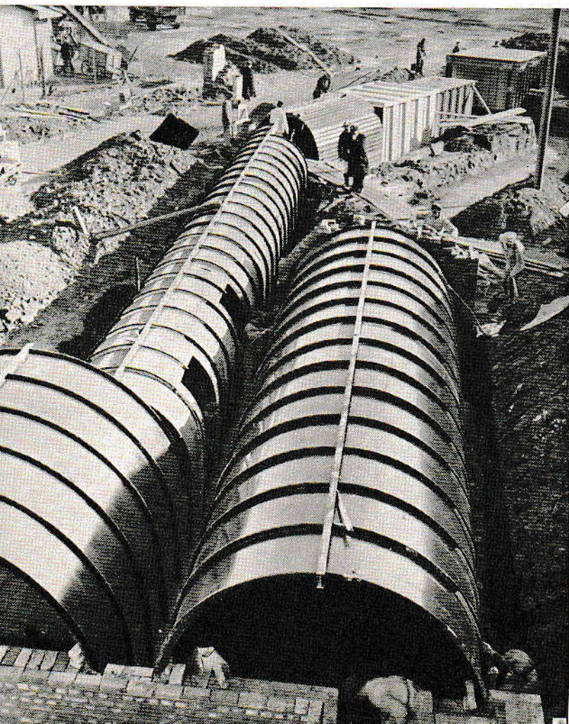
Fig. 243. Vue d'ensemble des abris anti-aériens de la foire de Leipzig. On voit les différents types constructifs adoptés.
